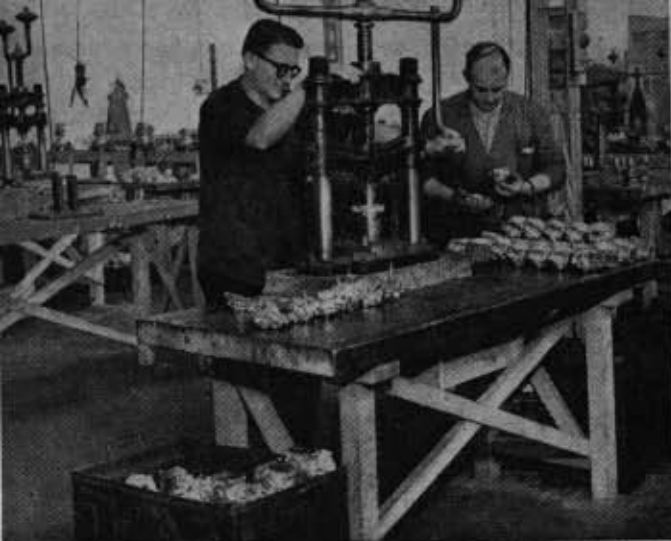
1. Mise en place au balancier, des roulements à billes de vilebrequin, dans les demi-carters
